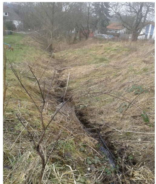
Wasserführender Graben mit verkrauteten Böschungen an der Südgrenze des Geltungsbereichs
